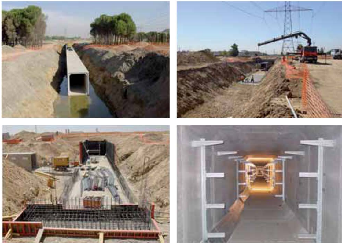
Figura 3. Construcción de la línea soterrada de alta tensión entre San Sebastián de los Reyes y Loeches (durante las obras, 2003).
